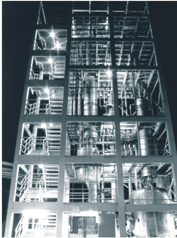
III. Metanol regeneráló, rektifikáló egység Sulzer rendezett töltettel
